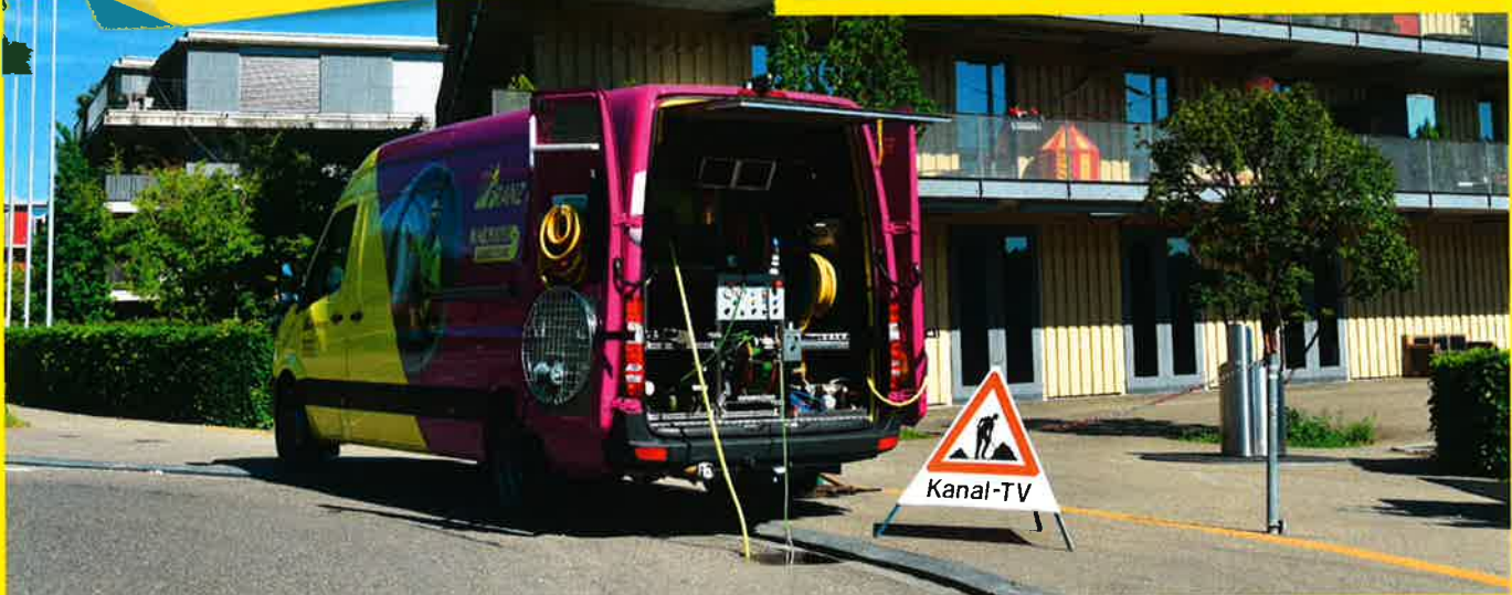
Mobile Einsatzzentrale der Franz Pfister AG: Reinigung, Vermessen und Dokumentation vor Ort
