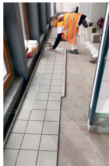
Verlegen des Plattenbodens mit rutschfesten Noppenplatten.
